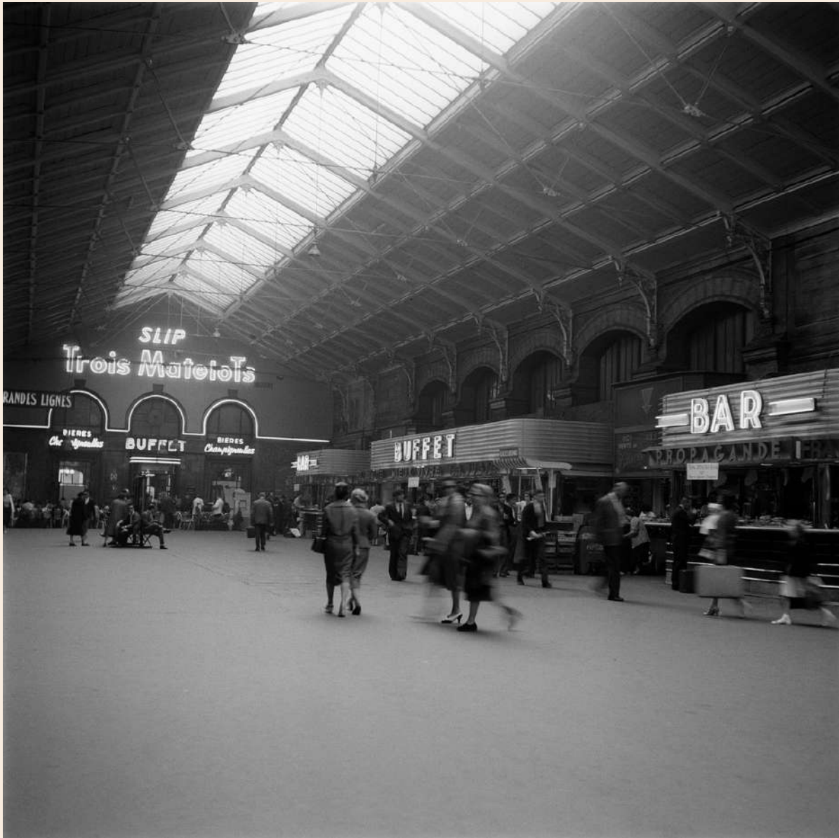
Salle des Pas-perdus Gare Saint-Lazare, 1958.
